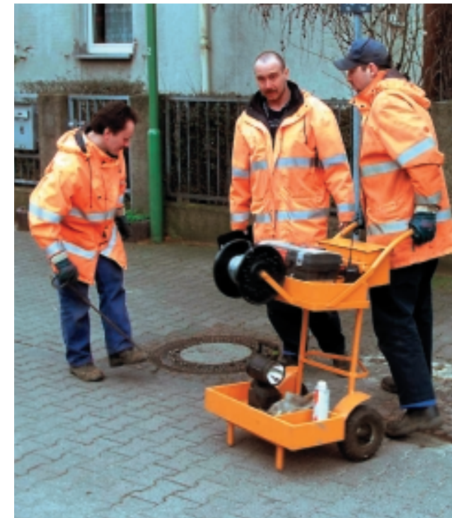
Speziell ausgebildete Teams sind bei der Stadtentwässerung Frankfurt am Main zur Rattenbekämpfung eingesetzt.
